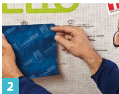
2 Incollare TESCON VANA PATCH
