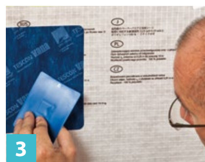
3 Strofinare bene con pro clima PRESSFIX
