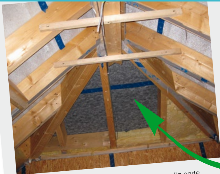
Un tetto, stesse condizioni, prestazioni diverse: nella parte centrale membrana SOLITEX MENTO
